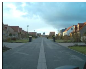
Rue du colombier – opération récente
